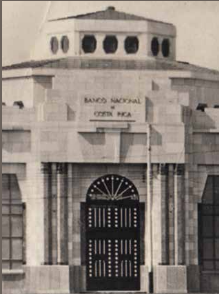
Edificio Banco Nacional
