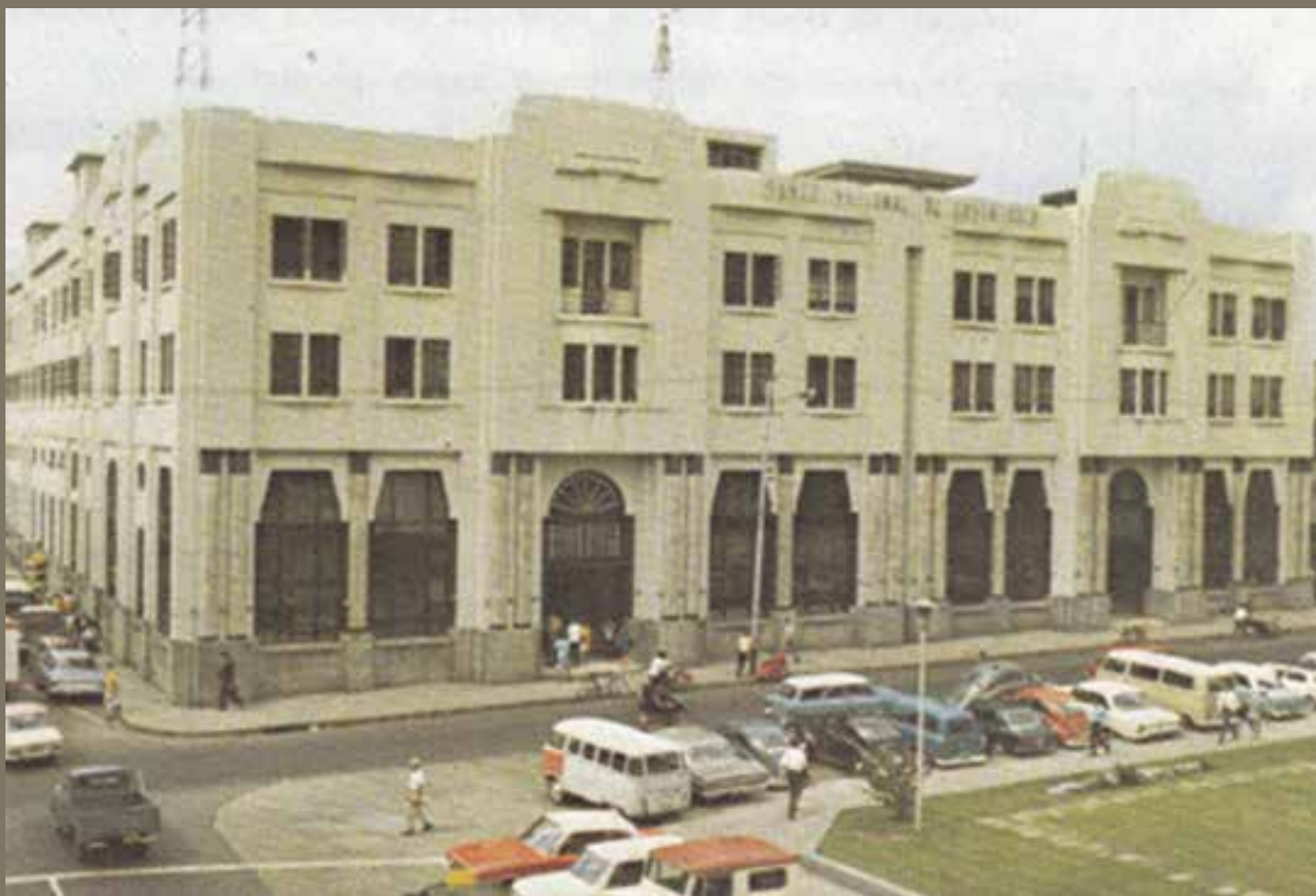
El edificio del BNCR en 1976.
